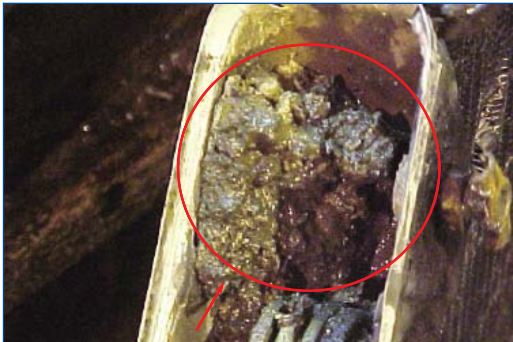
L'utilisation d'additifs pour cesser les fuites rend la garantie nulle
